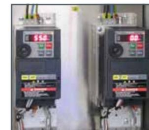
Frequenzumrichter zur Steuerung der Pumpen
