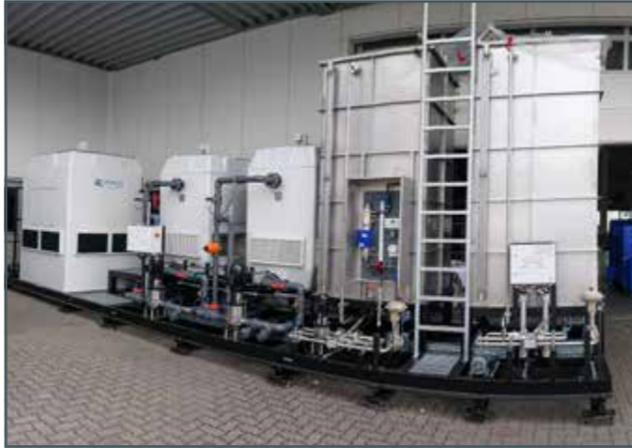
Nasskühltürme und Vorlagebehälter für Prozesswasser und Ethylen-glykol im Außenbereich
