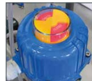
Elektrisch angetriebener Kugelhahn
