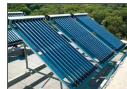
Röhrenkollektoren montiert im optimierten Anstellwinkel auf einem Flachdach
