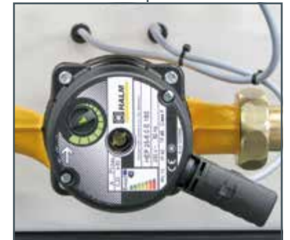
Energieeffiziente Umwälzpumpe mit einstellbarer Differenzdruck-Regelung (Effizienzklasse A)
