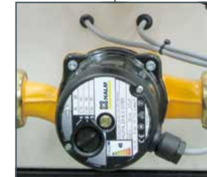
Ungeregelte Umwälzpumpe mit wählbarer Drehzahl (Effizienzklasse C)
