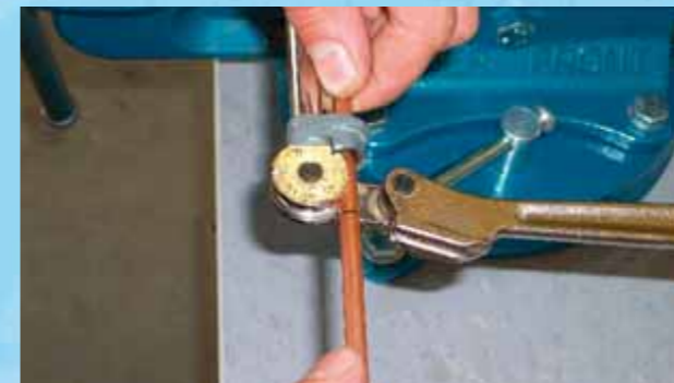
Einlegen des Rohres in die Biegevorrichtung
