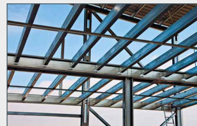
La construcción de los soportes
