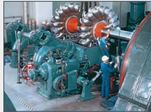
Montage einer Peltonturbine im Kraftwerk Walchensee, Deutschland (Voith Siemens Hydro Power)
