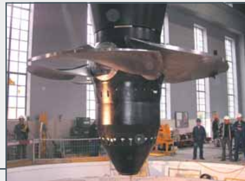
Einbau einer Kaplan turbine
