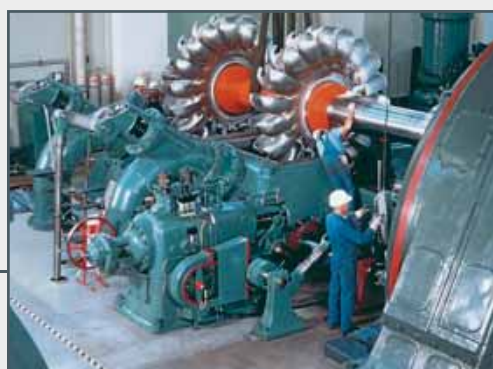
Montaje de una turbina Pelton en la central energética de Walchensee, Alemania (Voith Siemens Hydro Power)
