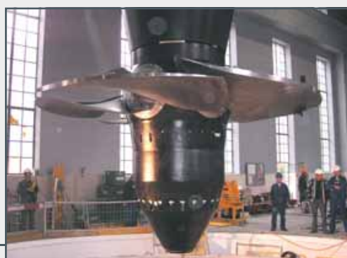
Montaje de una turbina Kaplan
