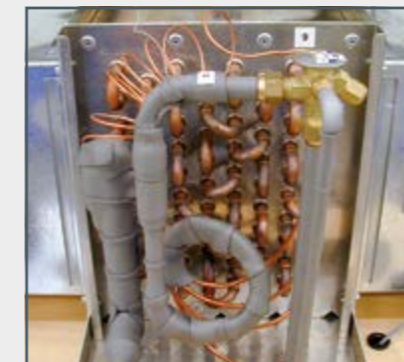
Evaporador directo como refrigerador de aire
