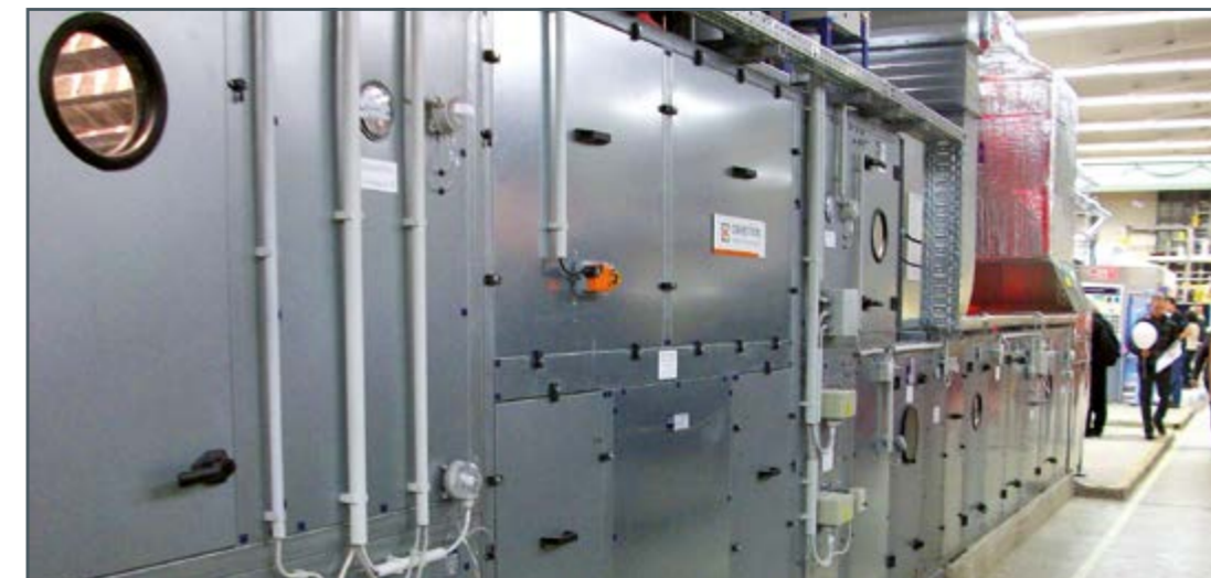
Evaporador directo como refrigerador de aire
