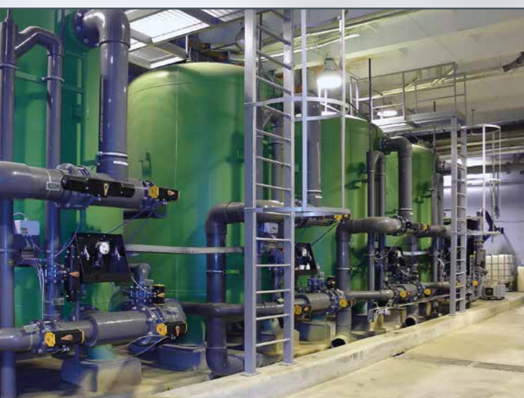
Kontinuierlich durchströmte Adsorber in einer Wasserbehandlungsanlage
